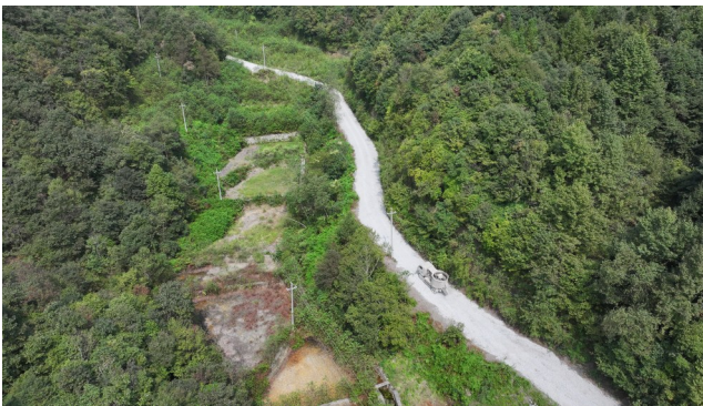
产业路修建现场
