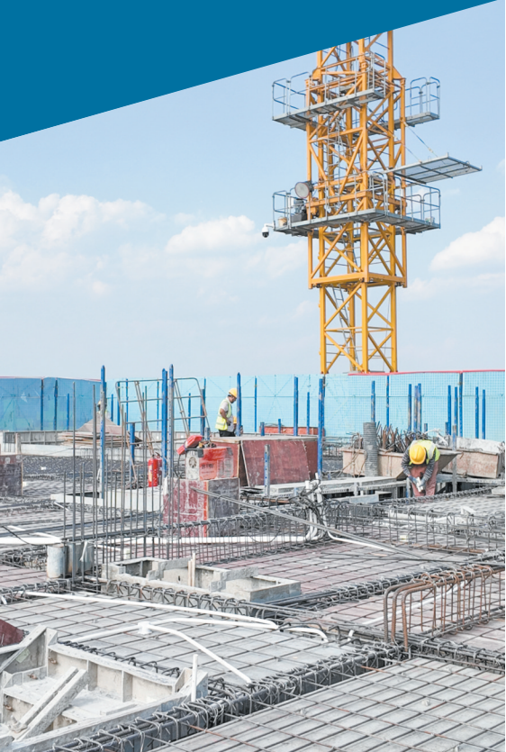
黔西百里城项目建设现场
