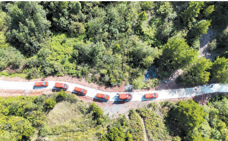
建成投用的森林防火应急道路
