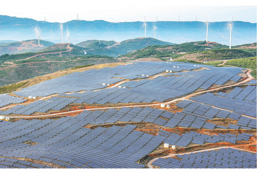
漫山遍野高架的光伏板在阳光下熠熠闪光，光伏板下各色时令蔬菜的幼苗破土而出。图为威宁平善光伏电站。
