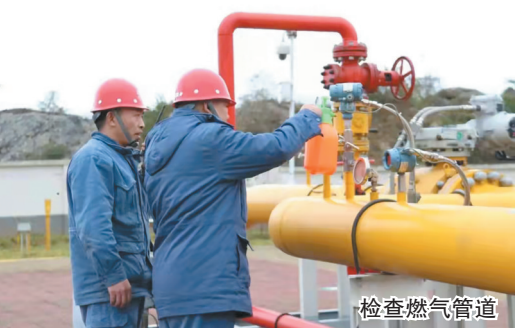
检查燃气管道
